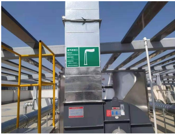
过滤棉+两级活性炭吸附装置+35m 排气筒
