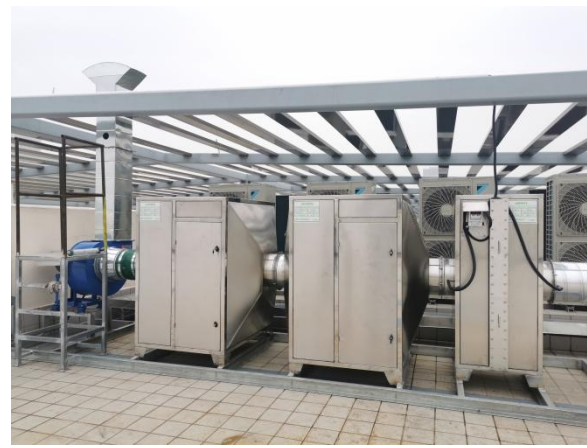
过滤棉+两级活性炭吸附装置+35m 排气筒
