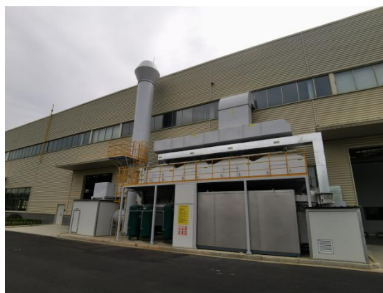
调漆、喷漆、流平、烘干、丝印废气治理设施 (洗涤塔+干式过滤器+活性炭吸附+脱附催化燃烧装置)
