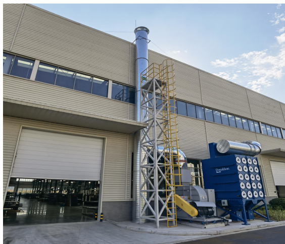
焊接烟尘治理设施 (滤筒除尘器)
