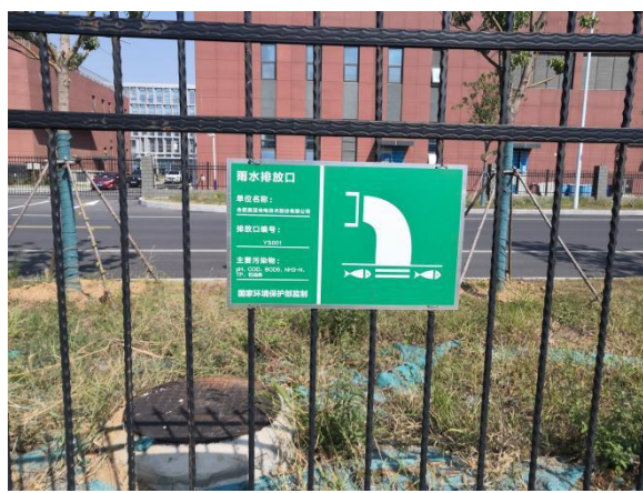
雨水排放口标牌
