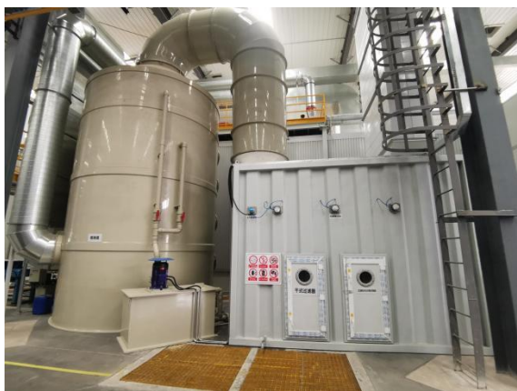
调漆、喷漆、流平、烘干、丝印废气治理设施 (洗涤塔+干式过滤器+活性炭吸附+脱附催化燃烧装置)
